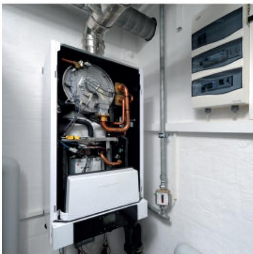
Par combustion, la micro-cogénération produit la chaleur utilisée pour couvrir les besoins en chauffage et pour la fourniture d'eau chaude. Si les besoins en chaleur de chauffage sont supérieurs à la quantité fournie par le moteur à combustion, une chaudière d'appoint intégrée couvre les besoins accrus.
